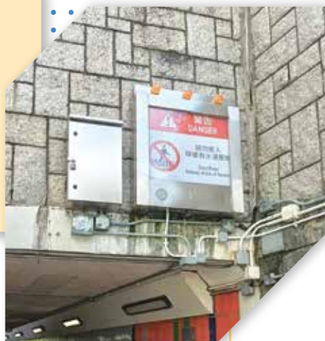
行人隧道外的水浸警告系統
